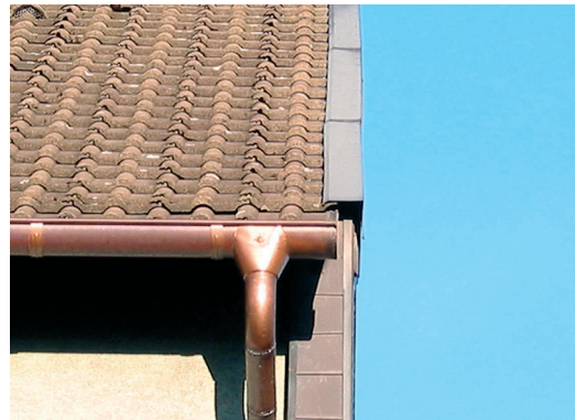
Abb. 1.1-33: Neue Rinne am Altdach.
