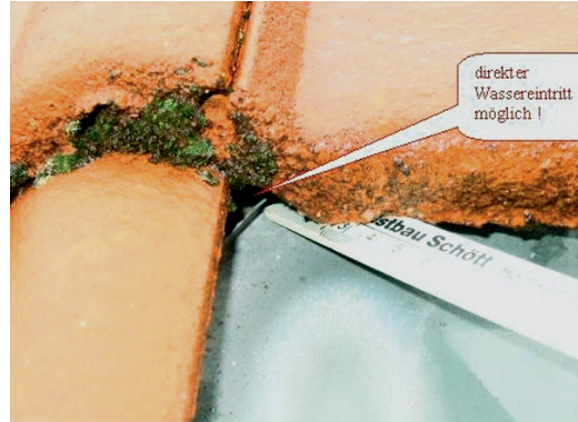
Abb. 1.1-25: Erst die direkte Untersuchung der Wasserläufer und der Kehle führt zur Leckstelle.
