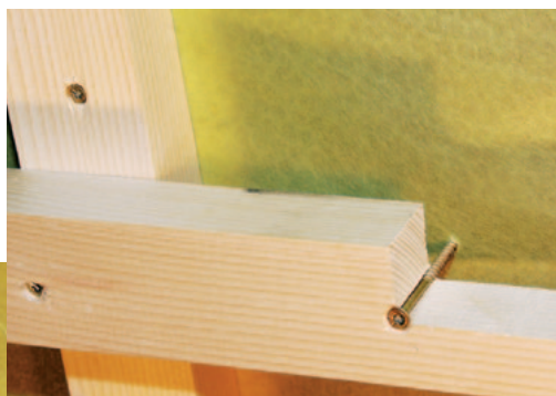
Schraube durchdringt Bahn im Gefach
